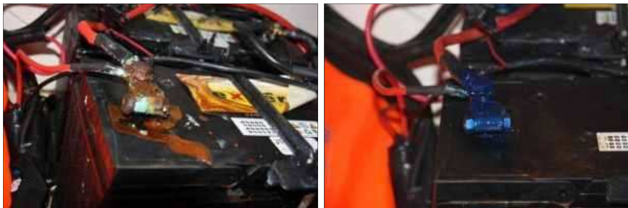
Αποκατάσταση πόλων συσσωρευτών
