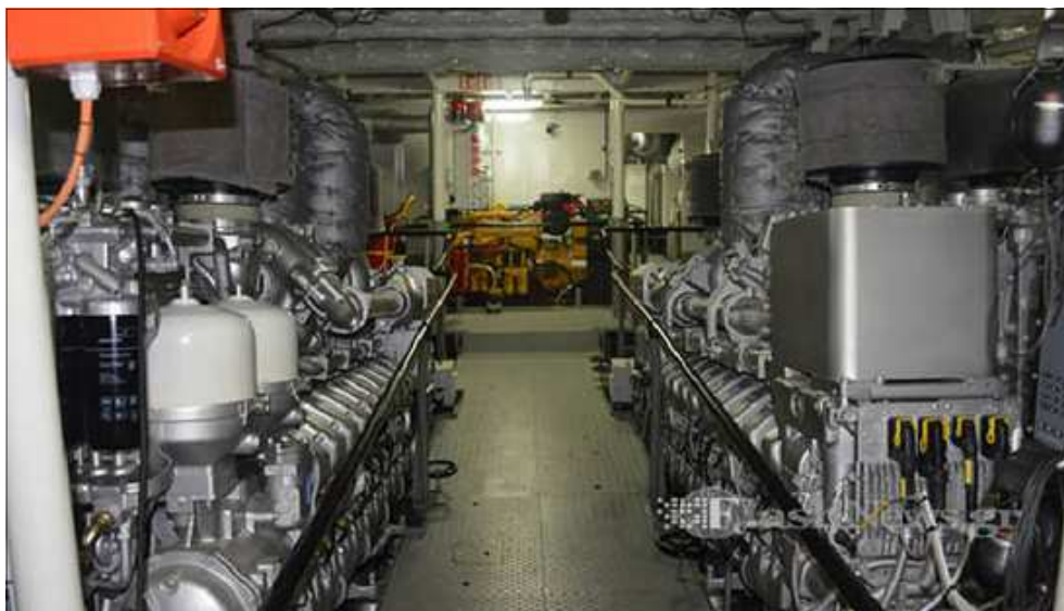
Μηχανοστάσιο του υπερσύγχρονου ταχύπλου σκάφους ΠΑΘ 090 «Γαύδος» του Λιμενικού Σώματος/Ελληνικής Ακτοφυλακής *Αντίστοιχα σύγχρονα μηχανοστάσια διαθέτουν και τα FLYING BRIDGE- SUPER-MEGA YACHTS κ.τ.λ
